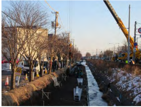
⑤鋼板の打込み（大型クレーン車）
