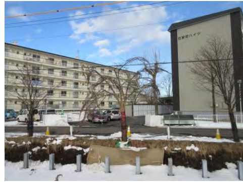
⑥鋼板打込みの完了
