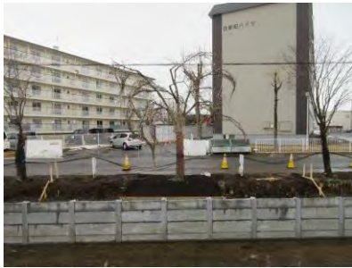
⑦護岸完了（正面）
