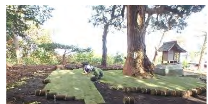
周辺表土保護、張芝状況
