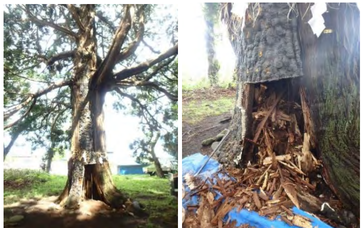
写真左：2017年ウレタン内部骨組角材破損状況 右：近景
