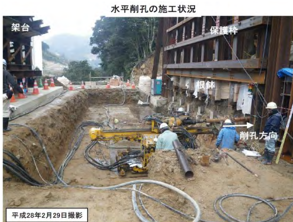
写真4 底部の補強 福岡県 HP より
