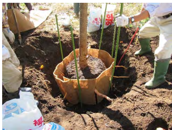
仕切り板設置状況
