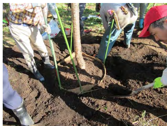
混合土、埋戻し土の充填
