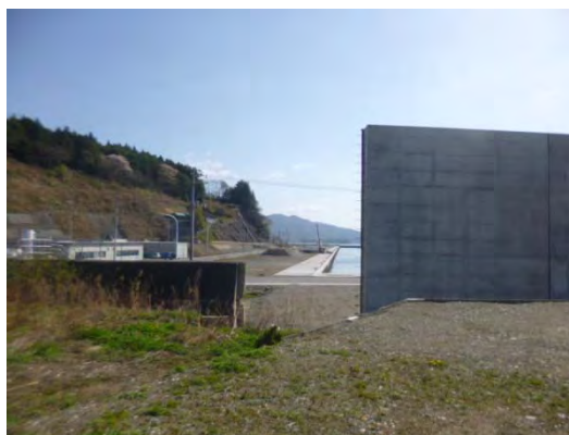
写真3 違いが歴然。左：旧防潮堤、高さ4m、右：新防潮堤、高さ12m
