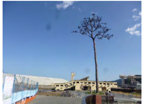
写真4 崩壊施設横には松林集団があった。
