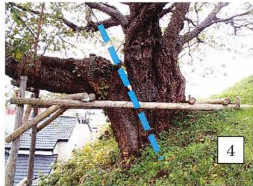
主幹部の縦割れが懸念される
