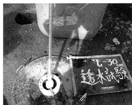
写真 1 長谷川式透水試験状況 (No. 2)
