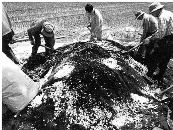
掘り上げた土と土壤改良材の混合
