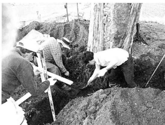
暗渠の施工状況
