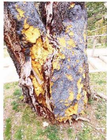
破損崩壊している发泡ウレタン
