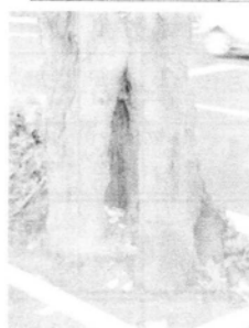
写真Ⅲ-2-6 根元の開口空洞
