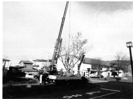
⑨吊り上げ運搬
