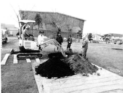
⑩植穴掘削
