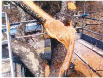
⑧腐朽患部の切削り整形
