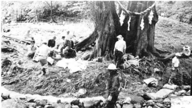
↑ (写真 2) 土嚢と覆い石の設置作業
