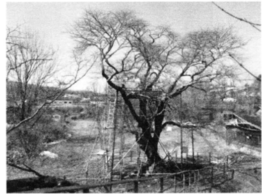
②足場の設置（北側法面より）
