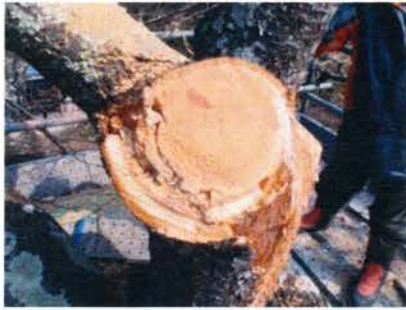
⑦切口腐朽材の除去
