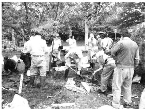
土壤改良材を混合し埋め戻し作業
