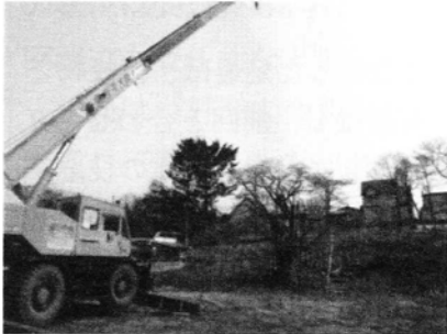
クレーン車による支柱建込み
