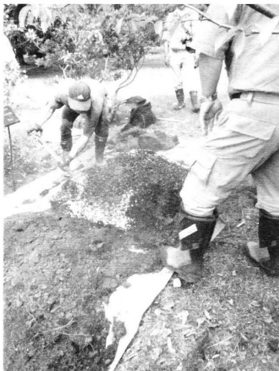
土壤改良材を混合し埋め戻し作業
