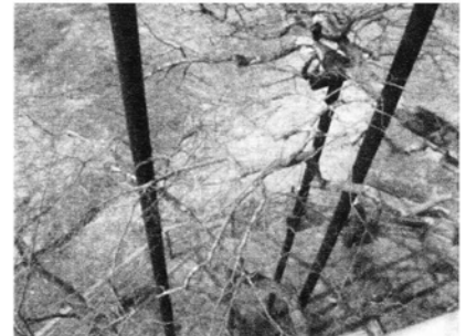
T字支柱設置完了
