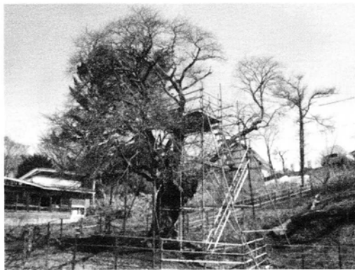
①足場の設置（正面東側より）
