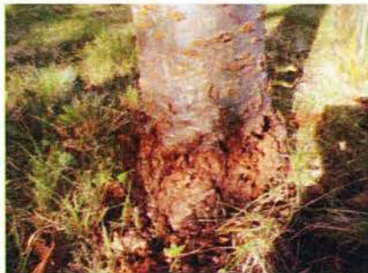
① 施工前(地際部)
