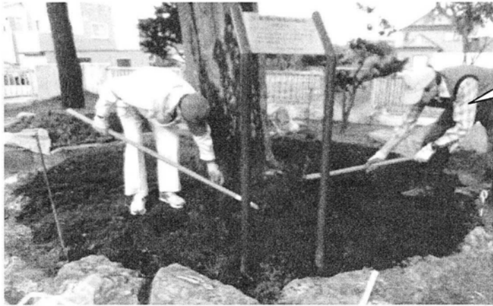
混ぜ合わせた改良材を、既存土壌と攪拌し、敷均す
