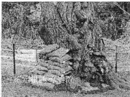
巨大な幹北側腐朽部の処置
