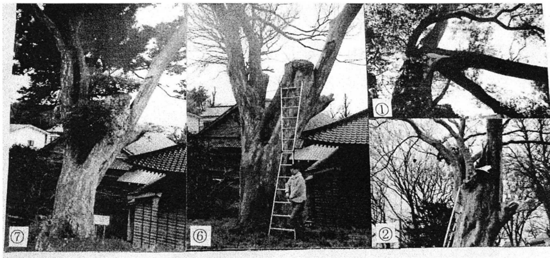
⑦ 補修4年後の繁茂状況 ⑥ 補修翌年の断面の状況 ① ② 台風で折れ、伐採されたケヤキ
