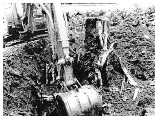
写真3 伐根作業。「ウロ」の内壁。H23. 11. 9。
