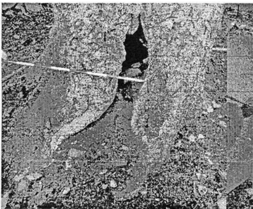
写真-3 空洞-1 (A) 拡大
