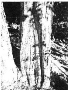
腐朽部の除去
