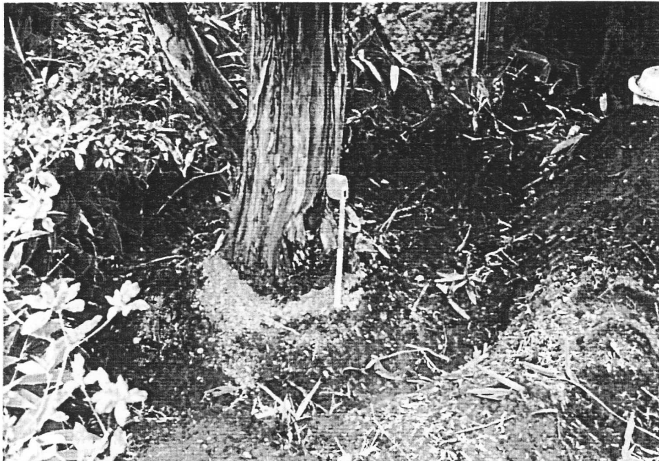
写真-5 火山れきとパーク堆肥の混合物で埋め戻す 元の地表より約10cm下げて整地する 2000(12).6.30
