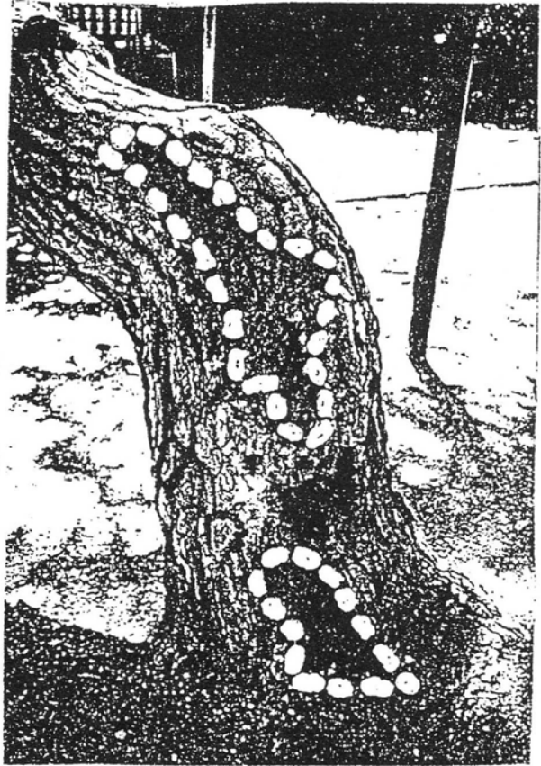
写真-1 上国寺の黒松の補修状況
