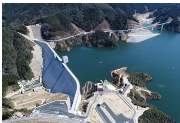
写真3 完成した五ヶ山ダム（ネット画像より）
